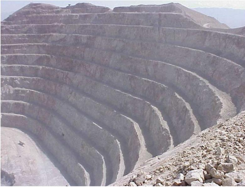
**Figura 7.** Talud con bancos en una mina a cielo abierto analizado con las herramientas de cómputo de estabilidad propuestas.
