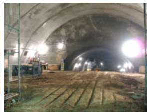
Excavación de banco
