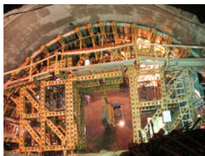
Hormigón de bóveda
