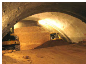
Excavación de bóveda
